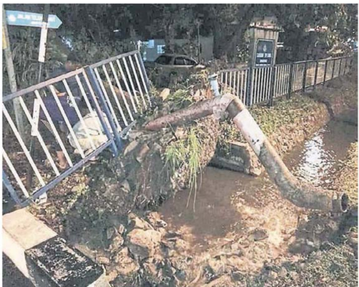
■万津德理玛花园一处主要水管遭倒下的大树压毁，当局立刻派员抢修。
